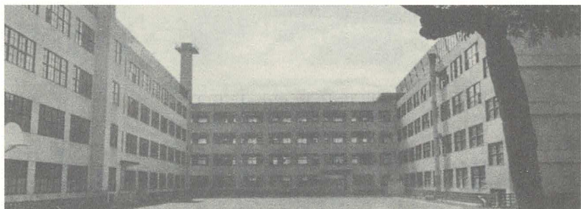
▲竣工(昭和39年6月)当時の2号館(正面左)
